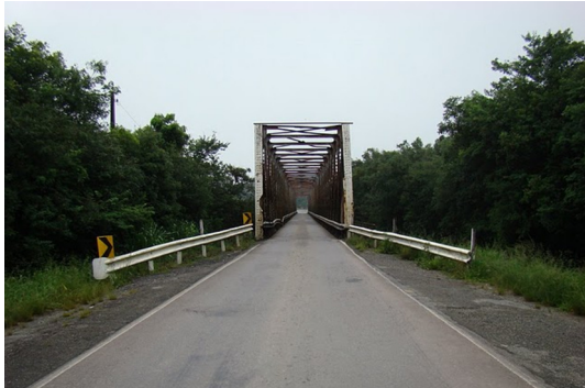
Ponte de Ferro
